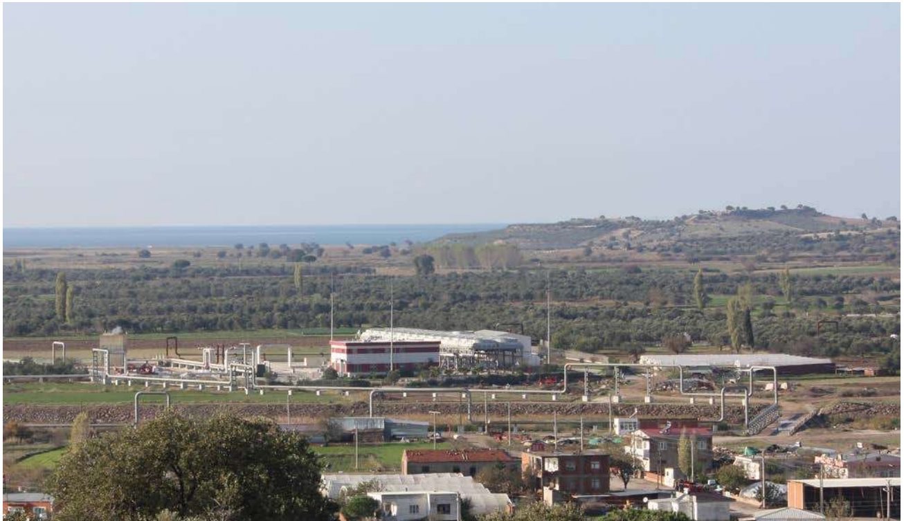
Görsel 4.1.13 Jeotermal Elektrik Santrali Ayvacık/Tuzla
